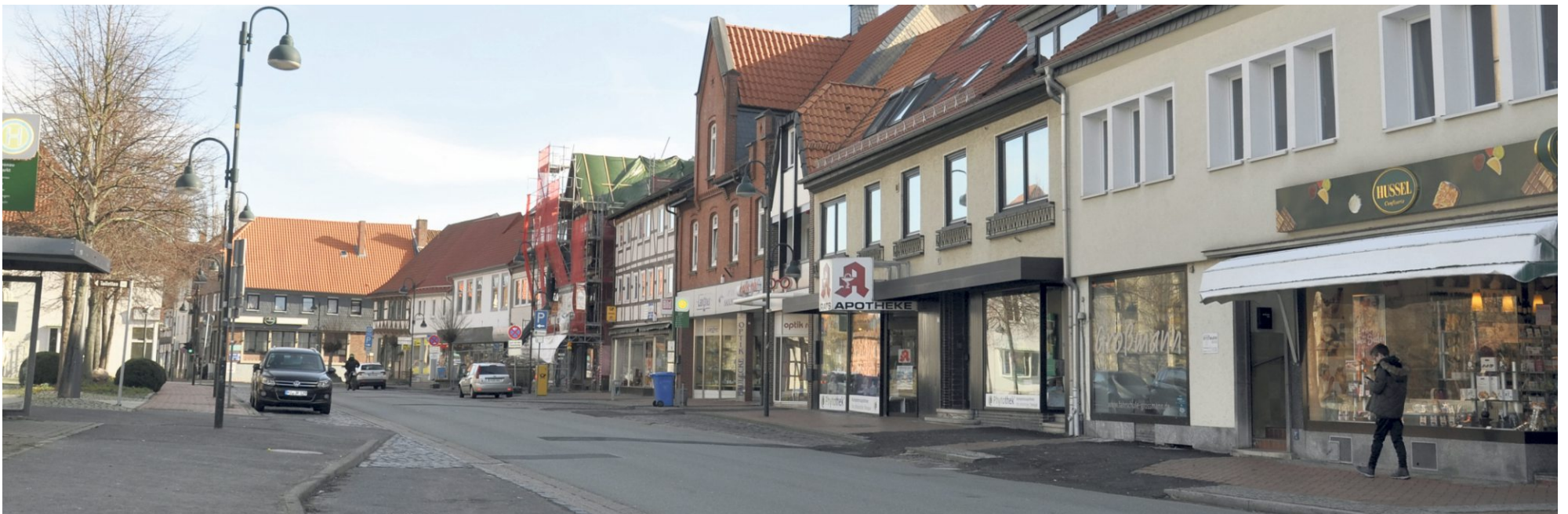
Noch ist es vergleichsweise ruhig an der Hauptstraße. Doch schon Ende März sollen hier wieder die Bagger und Baumaschinen rollen, um die Hauptverkehrsader durch Gronau zu sanieren.
