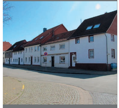
Putzfassaden im Sanierungsgebiet Gronau (Leine) Innenstadt
