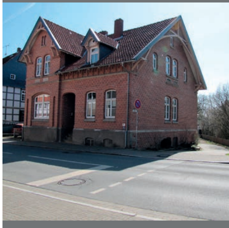
Backstein- / Klinkerfassaden im Sanierungsgebiet Gronau (Leine) Innenstadt
