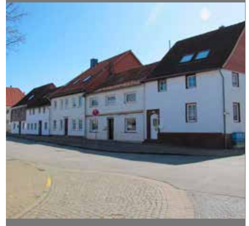
Putzfassaden im Sanierungsgebiet Gronau (Leine) Innenstadt
